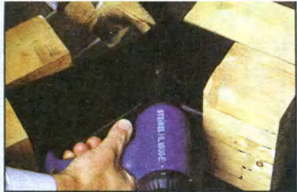
Мощные брусья рамы и сваренная из пленки ванна образуют бассейн мини-пруда.
