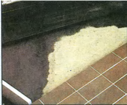
С использованием насланного под пленкой чистого песка дну пруда можно придать требуемую форму.
