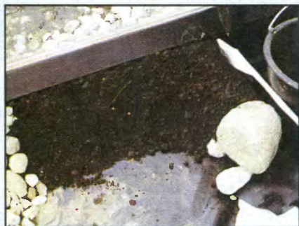
Откосы пруда формируют из тощей земли. Устойчивость откосам придает кварцевая галька.
